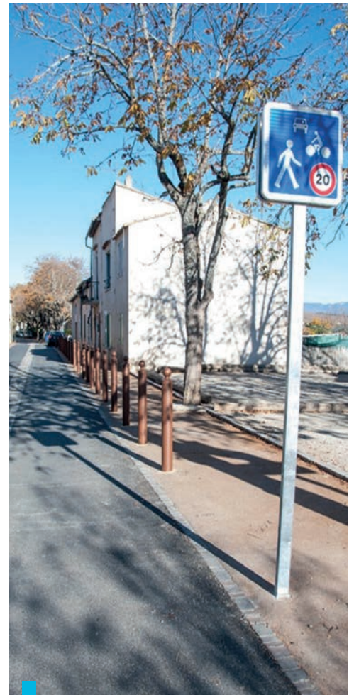
La rue du Barri a été rendue à la circulation en mai 2017.
