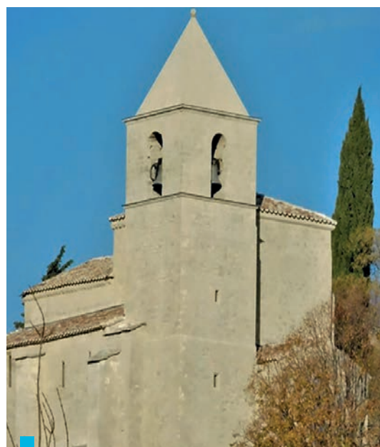
Fin des travaux de restauration du clos et du couvert de l'église en octobre 2017.
