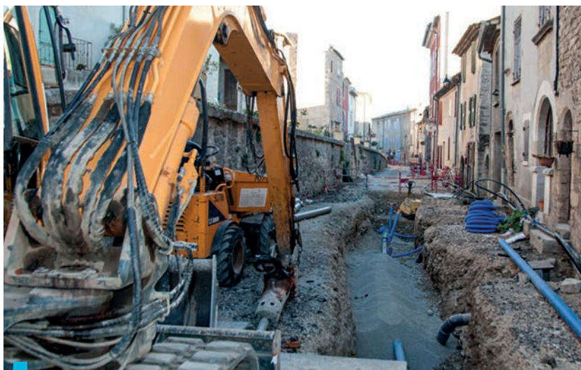
De septembre 2017 à mai 2018, le réseau d'eau a été rénové rue Grande et place de la Fontaine.
