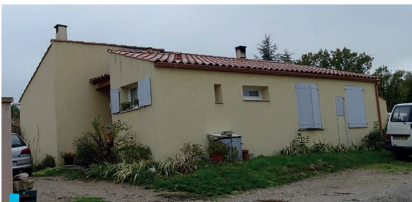
À Lincel, rénovation d'un gîte en 2015 et d'un appartement de la mairie annexe en 2019.
