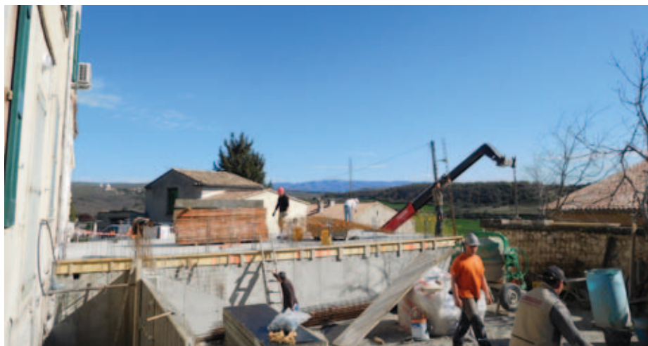
La réhabilitation de la mairie était devenue nécessaire afin d'améliorer les conditions d'accueil des habitants et de travail des agents et des élus.
